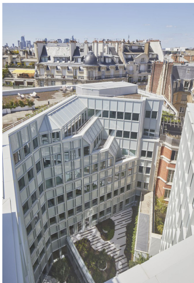
Figure 36 : Rénovation Belles Feuilles – Paris (75) – Basse Consommation - MO : Quartus – Architecte : DTACC
