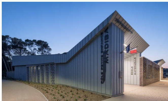
Figure 16 : Pôle petite enfance – Bepos Effinergie 2013 – Castelnau le lez (34) – MO : Ville de Castelnau le Lez – Architecte : KcomK Architectes
