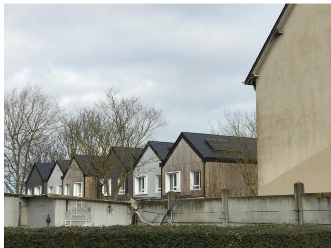
Figure 4 : Les Jardins de la Louisiane – Saint Malo (35) – BBC Effinergie 2017 – MO : Emeraude Habitation
