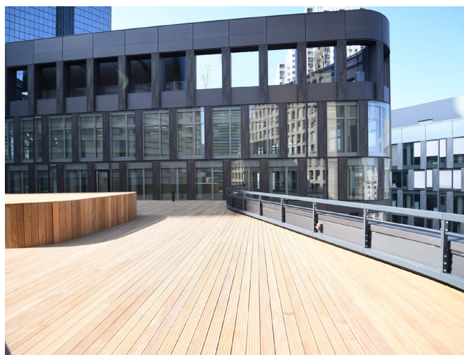
Figure 35 : Tour Watt – Courbevoie (92) – Basse Consommation - MO : Sogeprom – Architecte : Atelier 234
